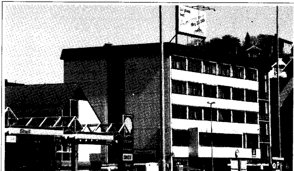
Pkt. 9 "Enkelt bygg - forretning".
